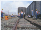
▲廃車を活用したカント区間を想定した脱線復旧訓練 (西浜駅)
