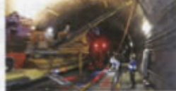
▲大規模改修工事
