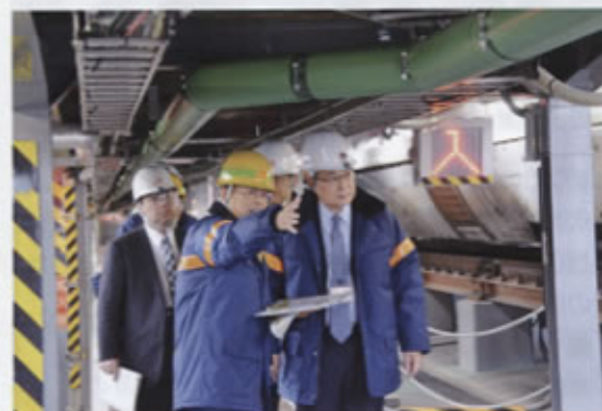
▲完成した引上1・2番線を視察する山田社長(1月26日)
