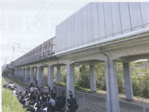
▲報道公開の様子（瀬田高架橋）
