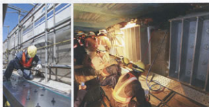
▲試験施工の様子
