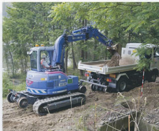
▲土砂の撤去・搬出作業の様子(伊勢竹原～伊勢鎌倉駅間)
