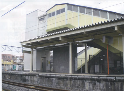
▲新設したエレベーター
