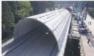
▲明かり区間(トンネル部以外)
