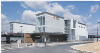
▲完成した相見駅
