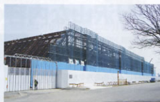
▲鉄骨建て方完了状況
