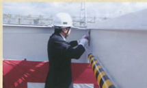
▲ポルト番付けを行う建設工事部山田担当部長
