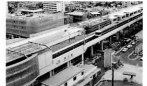
▲勝川駅付近の高架化
