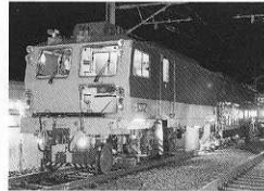
▲線路のゆがみを直す保線用機械
