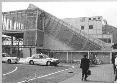
▲▼ 橋上駅舎化工事が完了した島田駅
