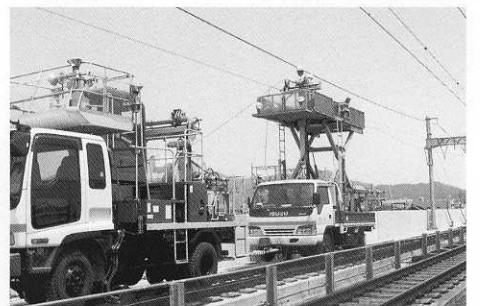
▲トロー線新設工事
