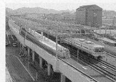
▲高架化した東海道本線・蒲郡駅
