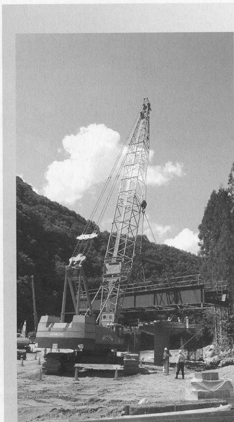
▲大型クレーンを使用しての桁架設工事
