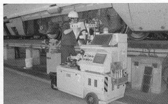
▲車軸探傷作業（車軸のキズの有無を検査）
