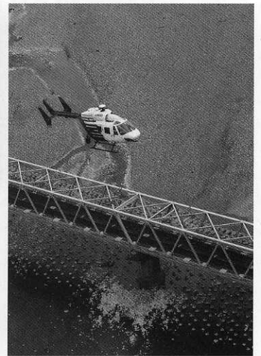
▲新幹線の線路・架線点検
